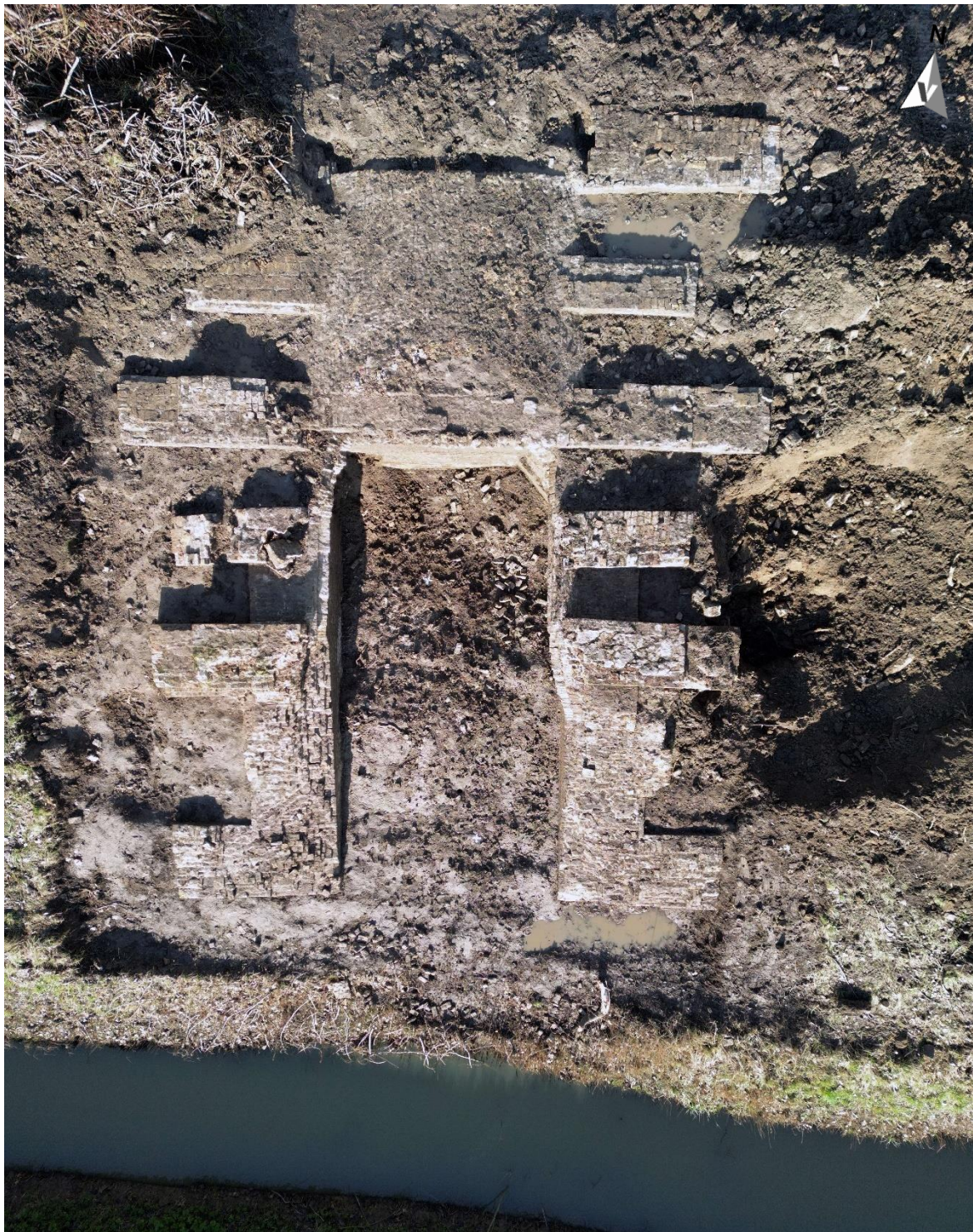
Afbeelding 9: Bovenaanzicht van de sluisconstructie met aan de onderzijde de koker met links en rechts de kokerwanden en daarbuiten de steunberen. Aan de bovenzijde ligt het gewelf over de koker, waardoor alleen de steunberen aan de zijkant nog te zien zijn. Noorden is aan bovenzijde van de foto. Foto: BVL De Winter.
