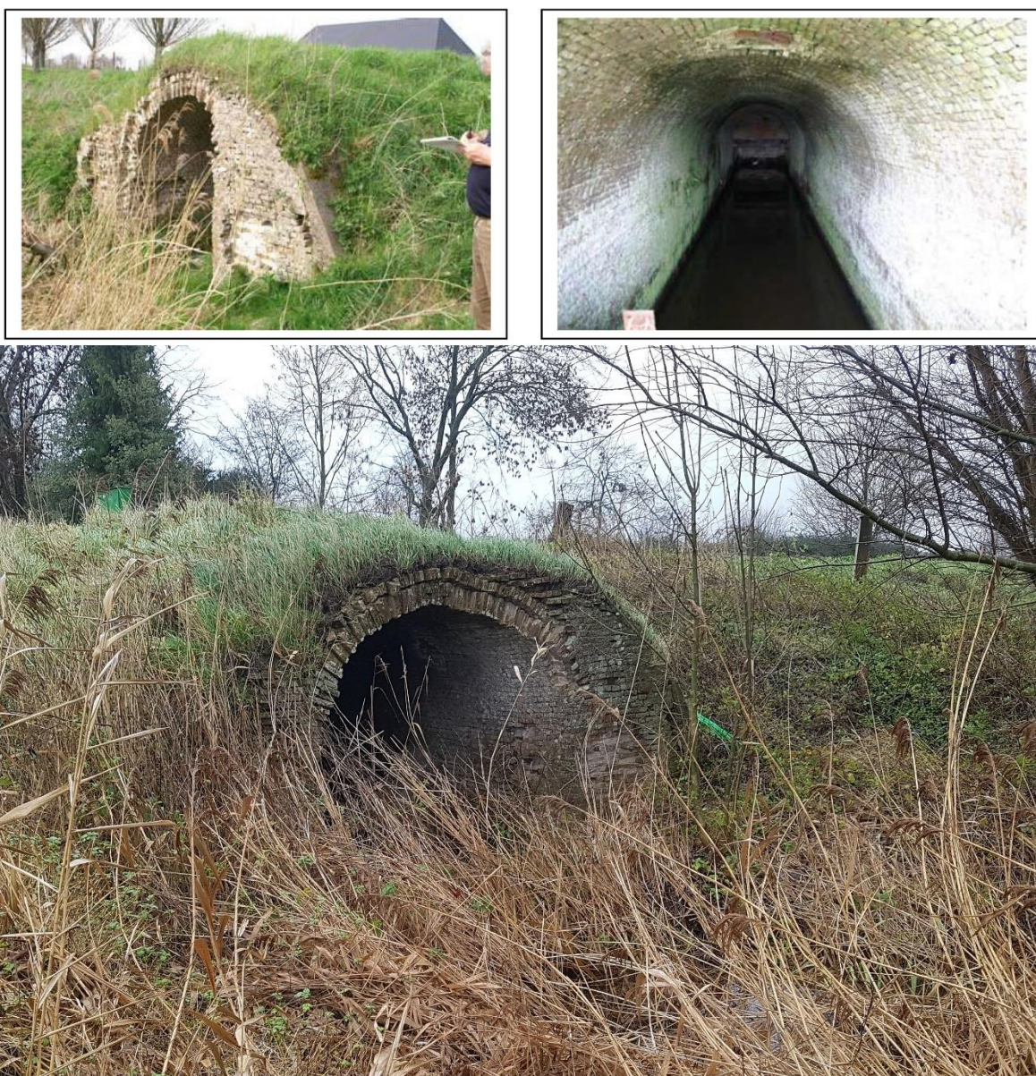
Afbeelding 14: De sluisconstructie Hoevense Wielen, een duikersluis of heul met een vergelijkbare metselwerk en gewelfconstructie. Foto: Waterschap Brabantse Delta.
