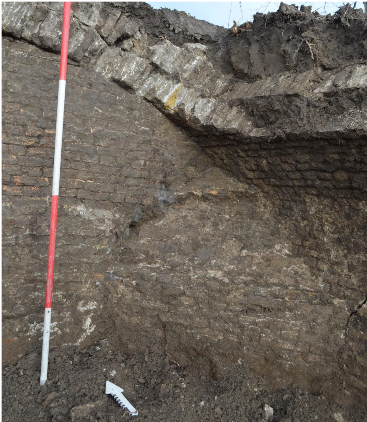
Afbeelding 16: De koepelvormige steunbeer in de sluiskoker, op de overgang van de kokerwand (rechts) en de dwarswand (links). Foto: Vestigia 2023.
