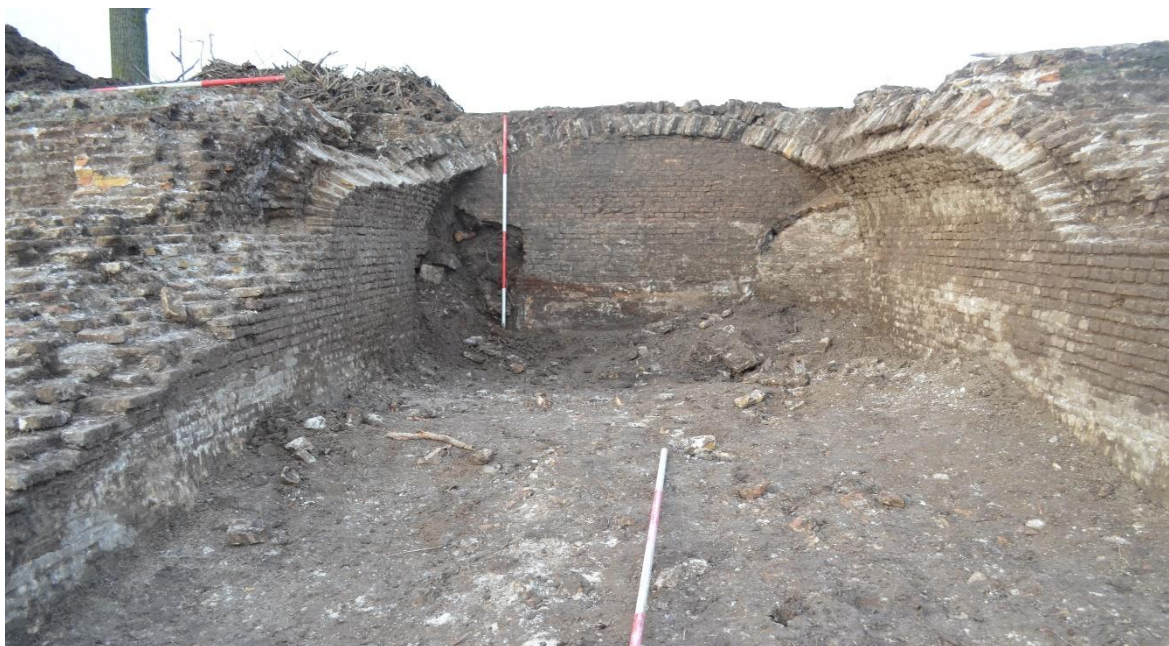
Afbeelding 13: Aanzicht in de koker naar het noorden met het koepelgewelf en wand dwars op de koker. Foto: Vestigia.
